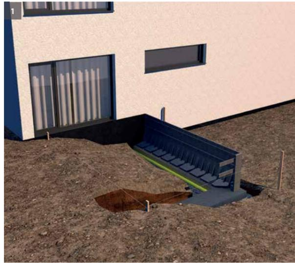
**Étape 1 :** Placez les murs en L sur la fondation en béton durci. En déplaçant les éléments, veillez à ce qu'ils soient bien alignés et installés verticalement.
