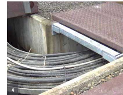
Mise en place des fers dans les angles
