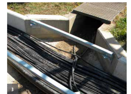
Pose de la baguette en métal dans les angles
