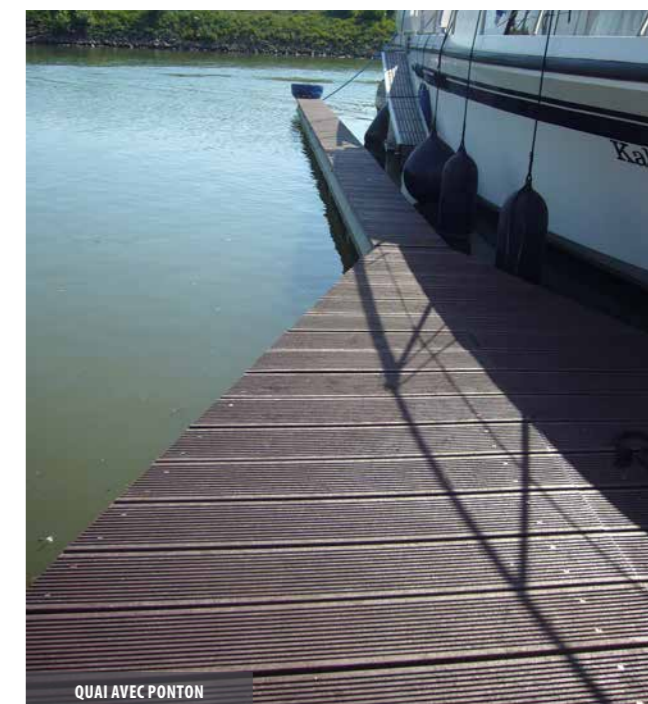
QUAI AVEC PONTON
