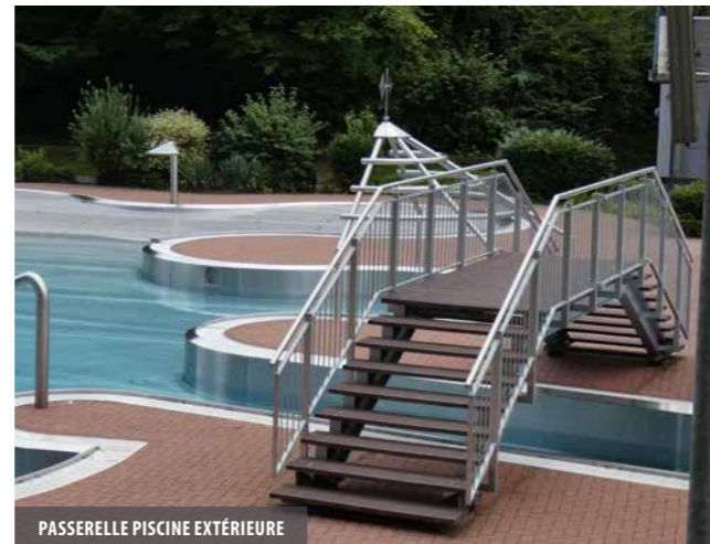
PASSERELLE PISCINE EXTÉRIEURE
