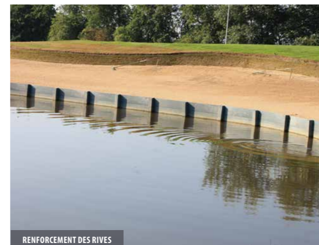
RENFORCEMENT DES RIVES
