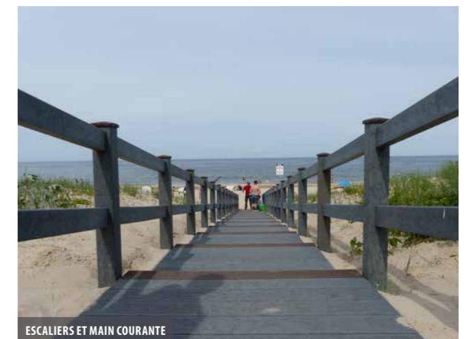
ESCALIERS ET MAIN COURANTE
