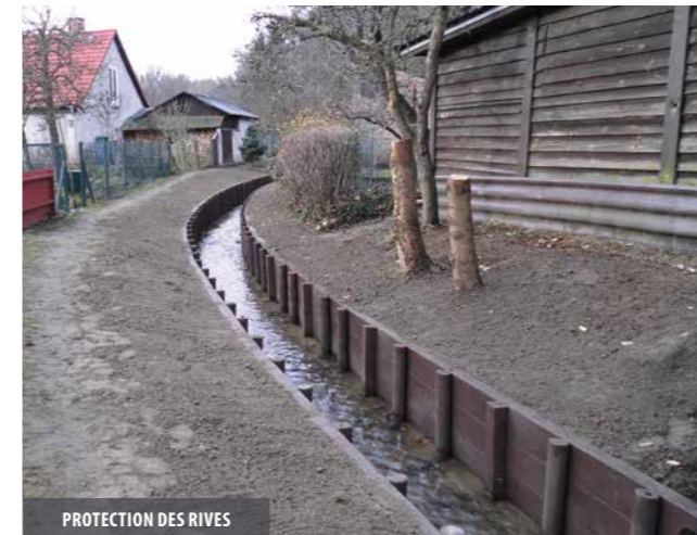
PROTECTION DES RIVES
