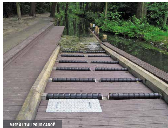
MISE À L'EAU POUR CANOË
