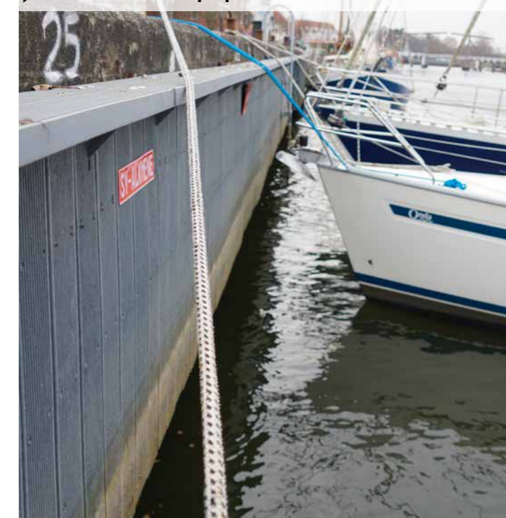
► Revêtement des palplanches à madrier
