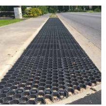
Les dalles alvéolées/paddock hanit® sont la solution pour un sol drainant et résistant : l'alvéolage permet l'évacuation rapide des eaux pluviales
